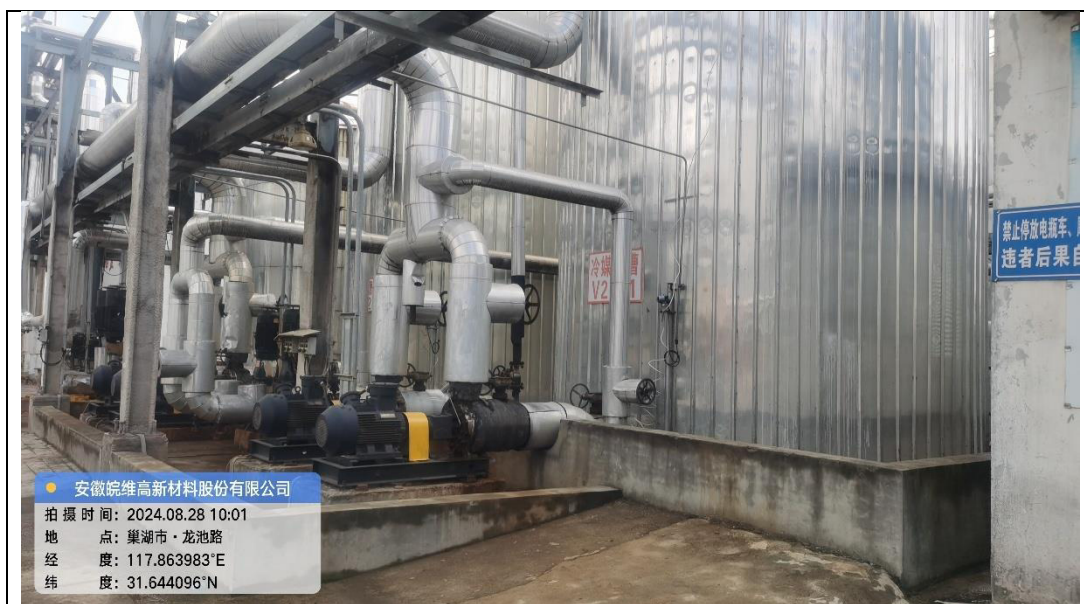
图 4.1-1 部分储罐现状图
