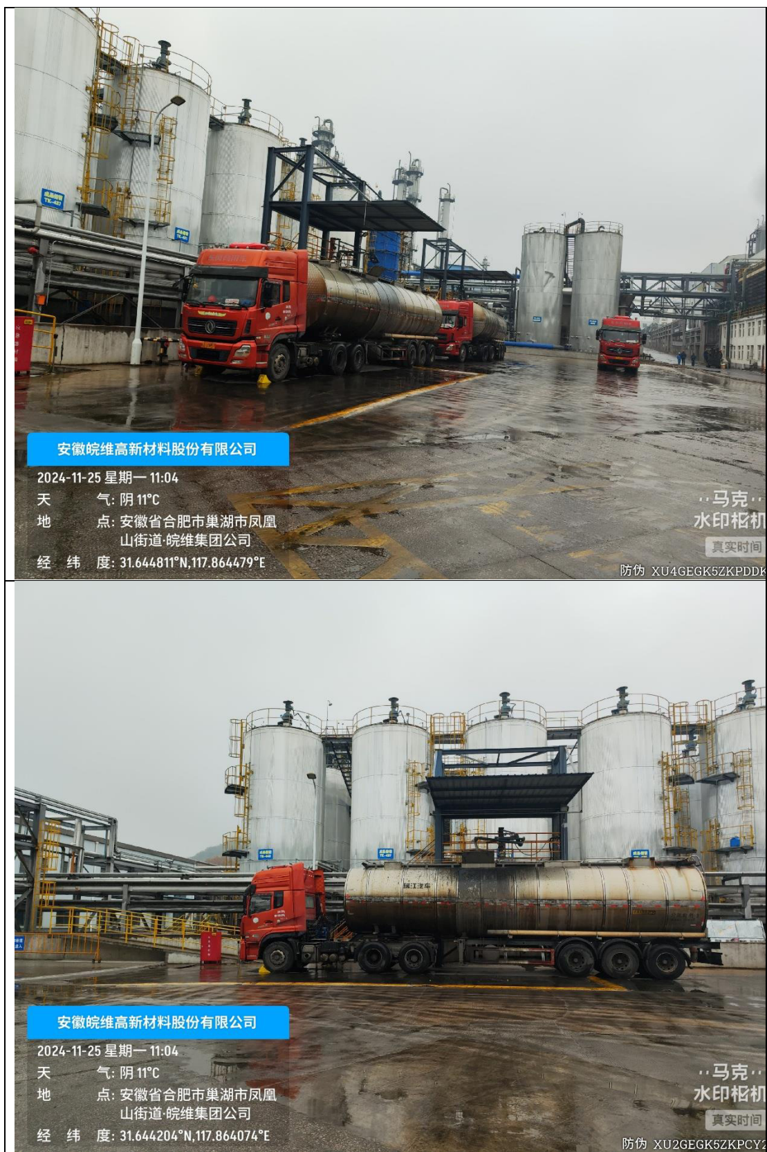
图 4.1-4 散装液体物料装卸区现状图
