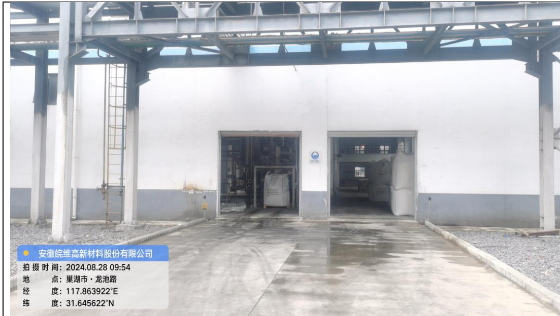
图 4.1-7 部分固态物质存储和暂存现状
