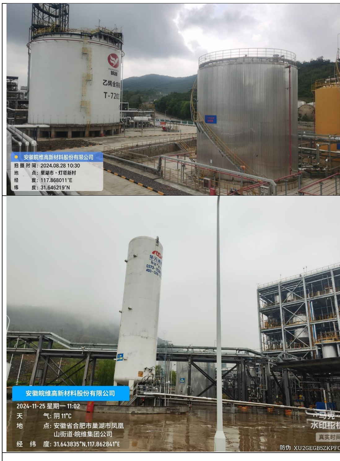
图 4.1-2 部分储罐现状图
